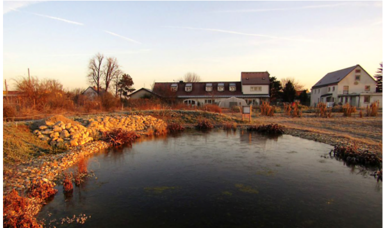
Abb. 2: Blick auf das Institutsgebäude der BFA. © C. Ableidinger.
