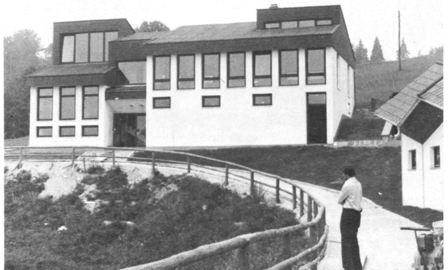
Das Verwaltungs- und Betriebsgebäude
