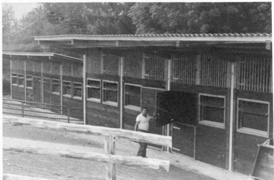
Die bereits fertigen Stallungen
