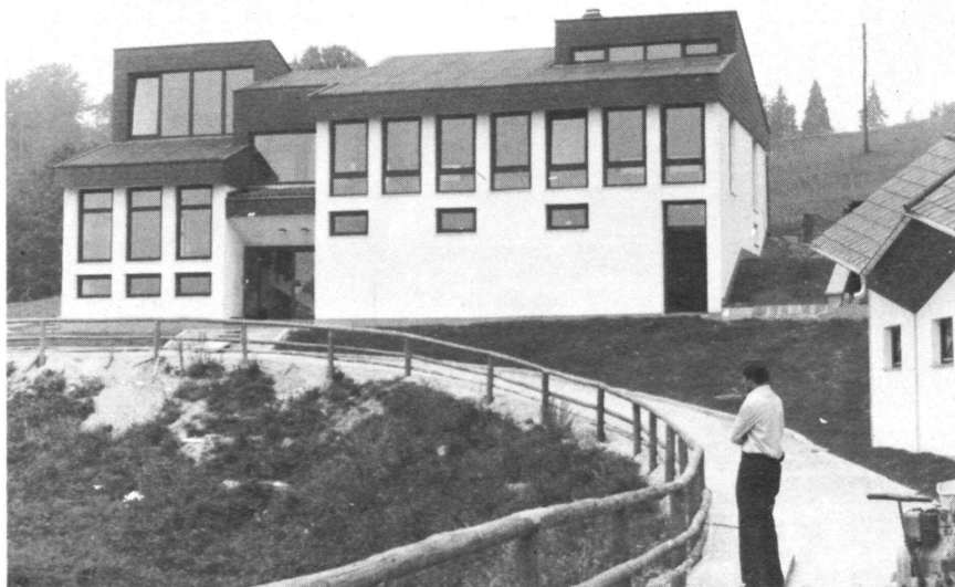
Das Verwaltungs- und Betriebsgebäude
