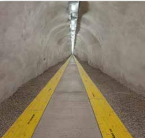
Der **410 m lange Experimentalstollen** des GMO durchquert den Tafelberg in 1.100 m Seehöhe. Er ist Teil der über 1.000 m langen Tunnelanlage für höchstempfindliche Magnetfeldsensoren.
