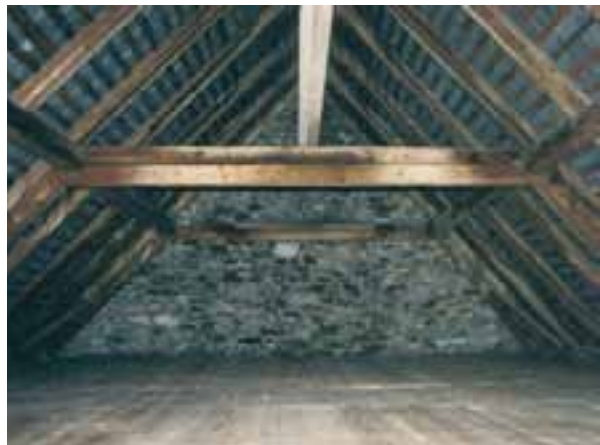
Dachraum der Kirche in Vezzan mit eingezogenem Zwischenboden (vp).
