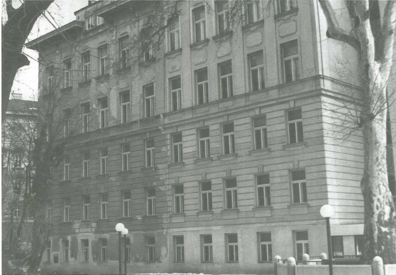
Abb. 12. Winter 1987/88, Westtrakt. Links die noch desolante Fassade des Altbestands, rechts die aufwendig nach dem alten Muster ergänzte Fassade des neuen Teils. Es war eine Pionierleistung, die Fassade der Jahrhundertwende in mehrschaliger Bauweise exakt zu rekonstruieren. Um den Kern aus Eisenbeton befindet sich die Wärmedämmung, weiters eine Ziegellage und darauf wiederum die Schichten des Putzes. Um den Erfordernissen des erhöhten Wärmeschutzes gerecht zu werden - die statisch erforderlichen Auflageschuhe aus Stahl bedeuten für jedes Stockwerk eine Kältebrücke - und weiters durch die Gliederung der alten Fassade gab es außerordentliche technische Schwierigkeiten. – Photo: M. HESSE.
