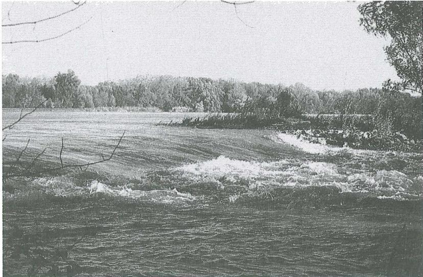
Abb. 10: Durchlässe am Treppelweg (oben) versorgen die Au an 222 Tagen pro Jahr mit Wasser, die Absenkung des Treppelweges (unten) bringt an 152 Tagen echte Fließdynamik. – Inlets in the Danube embankment (upper photo) allow water to flow into the floodplain for 222 days of the year, and lowering the embankment provides heavy flow on 152 days.
