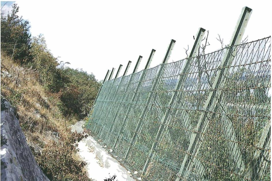
Abb. 7: Im ehemaligen großen Steinbruch am Nordosthang wurden mächtige Steinschlagrechen zum Schutz der Straße gebaut. – Fig. 7: In the former quarry on the northeastern slope, huge constructions were built to protect the road from falling rocks.
