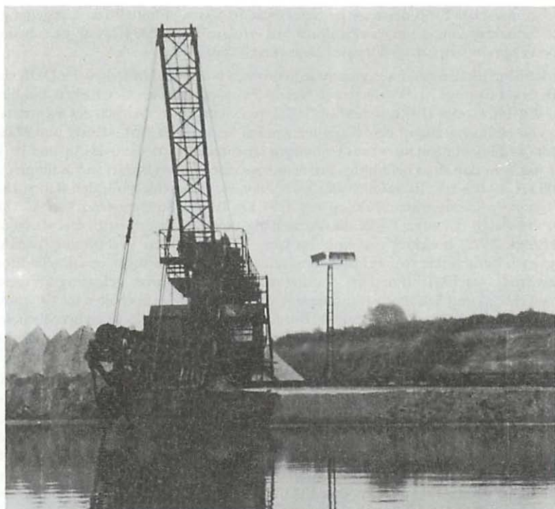
Abb. 2 Abbau von glazifluvialen Kiessanden im Naßschnitt mittels Eimerkettenbagger im Tagebau Koschendorf des VEB Zuschlagstoffe und Spezialsande Haida Foto: HANISCH 1977
