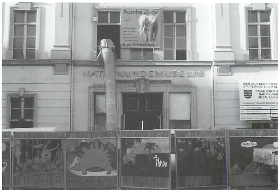
Eingang des Naturkundemuseums als Baustelle
