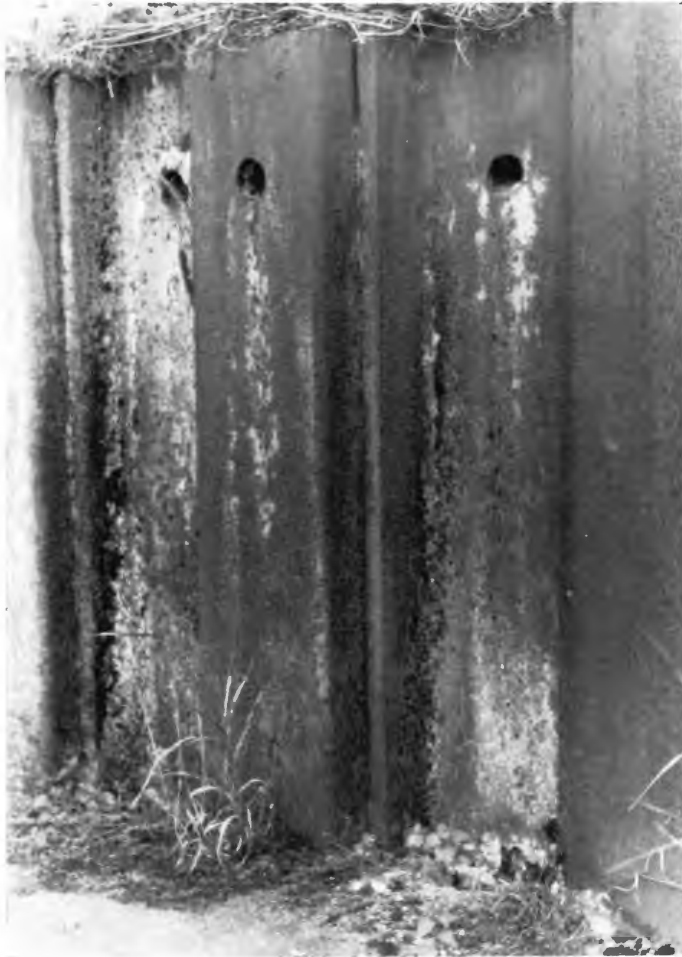
Abb. 63: Uferschwalbenbruten in einer Spundwand am Westicker Wehr bei Fröndenberg, Kr. Unna (A. Bock).
