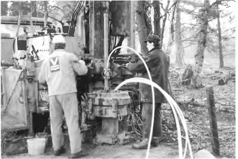
Abb. 6: Einbau des Rohrstrangs am Multilevel-Brunnen ML 2 durch die Firma B. Vormann.
