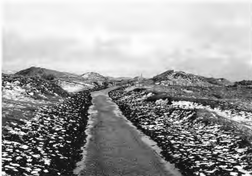
Abb. 63: Befestigung von Wegrandbereichen durch Humusauftrag im Mittelteil von Norderney
