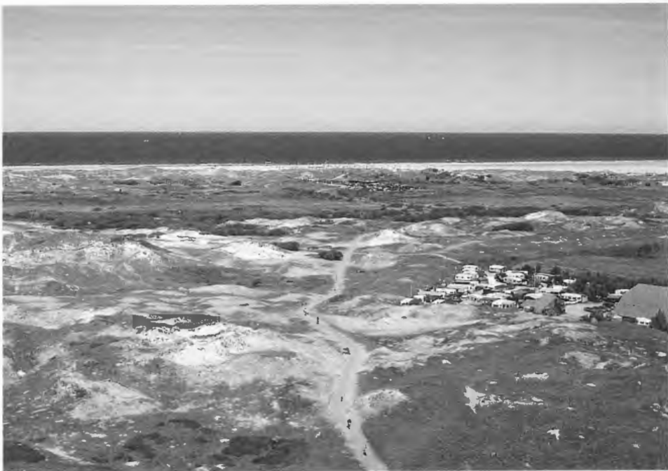
Abb. 51: Trittschäden im Bereich des Campingplatzes Domäne-Eiland im Ostteil von Norderney
