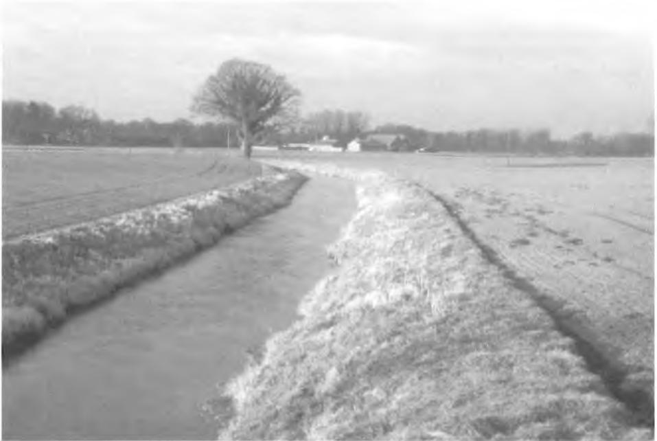
Abb. 1: Stark begradigter und ausgebauter Bachlauf am Eltingmühlenbach.
