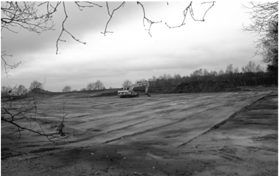
Abb. 2: Abschieben des Oberbodens auf der „Greiweschen Fläche“ im Januar 2004.
