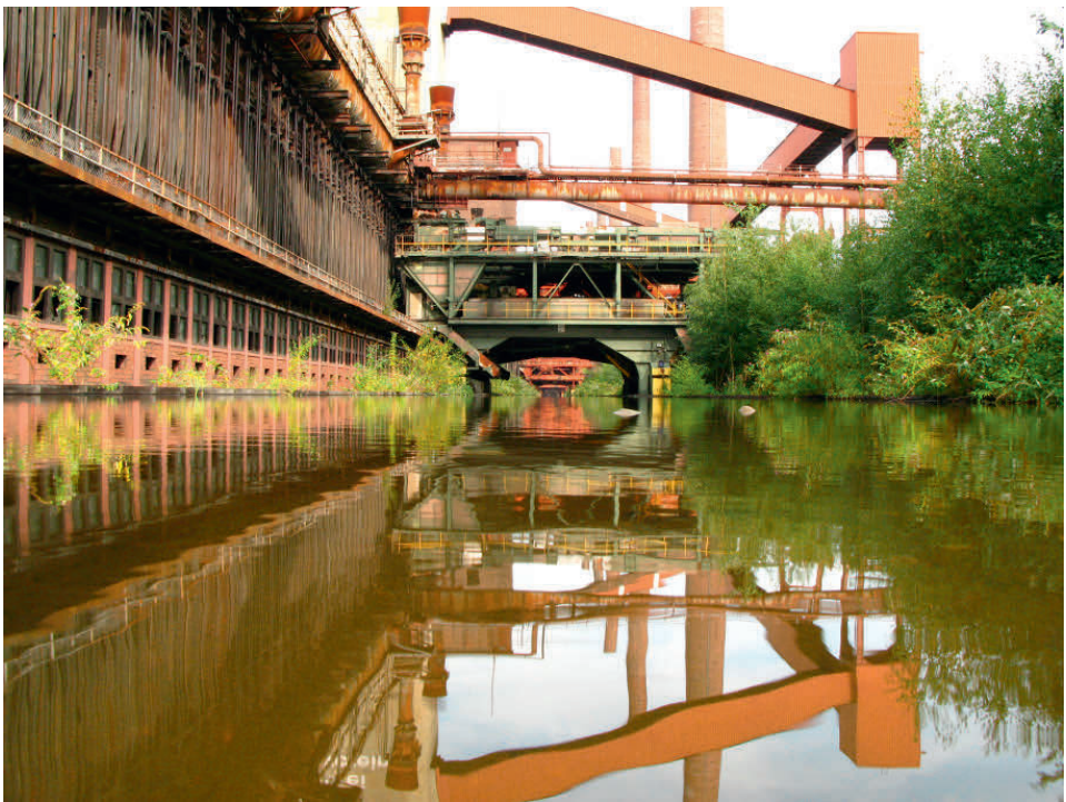
Abb. 22: Das große ca. 500 m lange Löschbecken auf der Südseite der Kokerei wird im Winter seit einigen Jahren als Eisbahn genutzt (Foto: Sabine Senkel, 1.5.2009).
