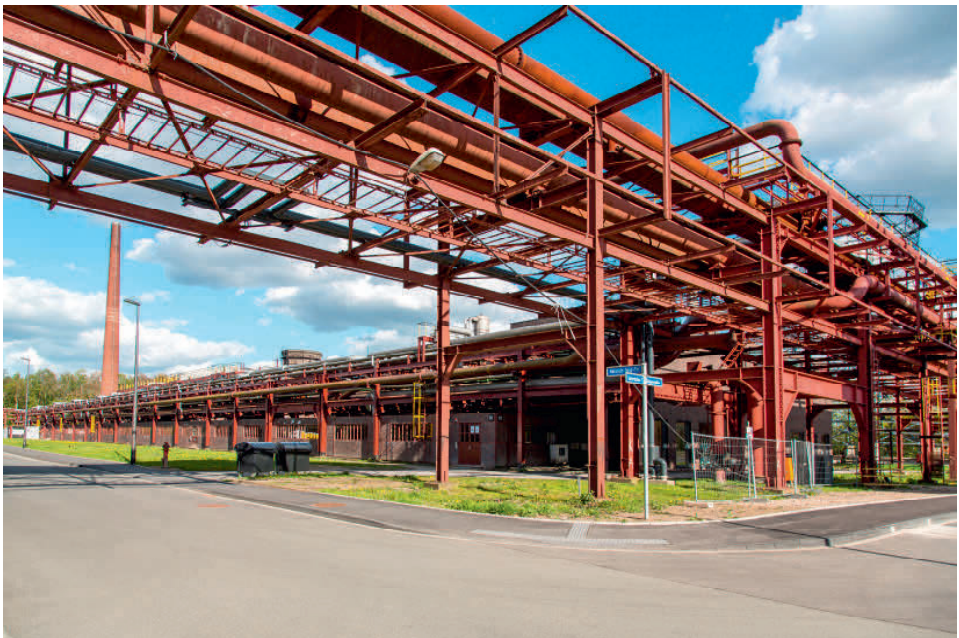
Abb. 13/14: Stillgelegte Industrieanlagen bieten Gebäudebewohnern einen Lebensraum (Fotos: Esther Guderley, 9.7.2013, © Jochen Tack/Stiftung Zollverein, 3.5.2016).
