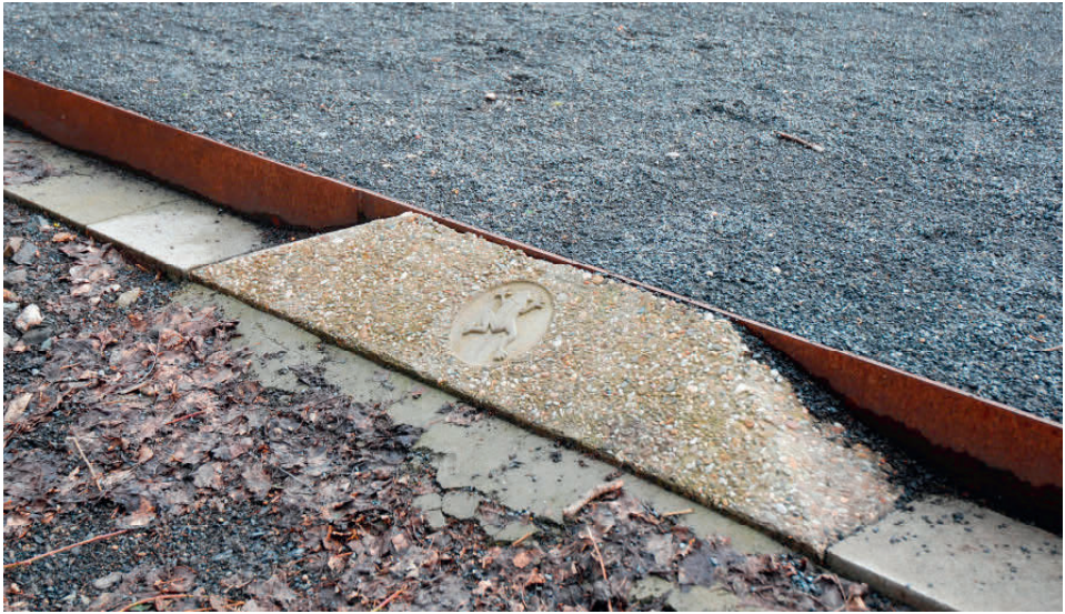
Abb. 12: An der Ringpromenade auf Höhe des Skulpturenwaldes angebrachte "Frosch-Trittsteine" erleichtern Amphibien die hohe Einfassungskante der Wegebegrenzung zu überwinden (Foto: Hamann & Schulte).
