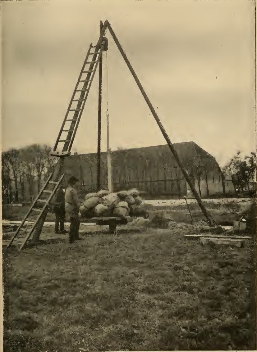
Sumpfgasbohrung in Strückhausen.
