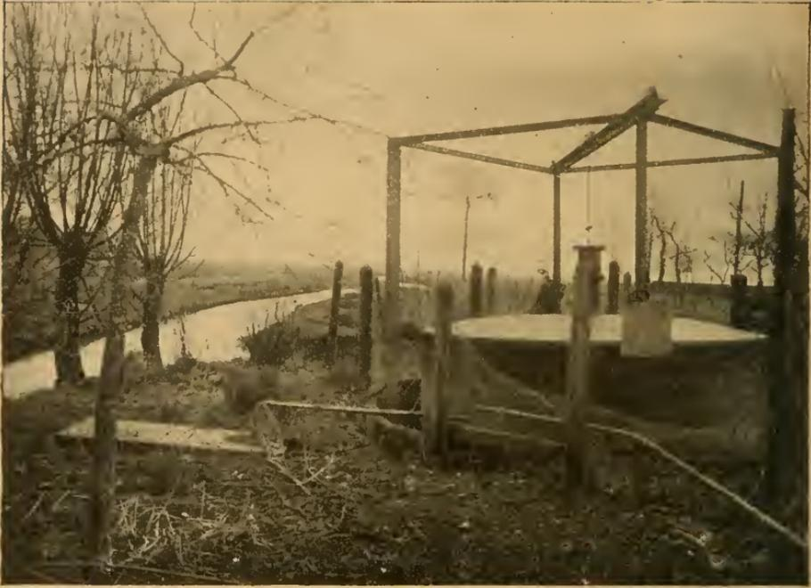
Verdeckter Gasbrunnen und Hauptgasometer einer Sumpfgasanlage
