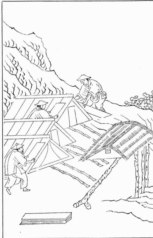
Abb. 2: Bau des Ofens (*Mo-p'u* 1,2a)
