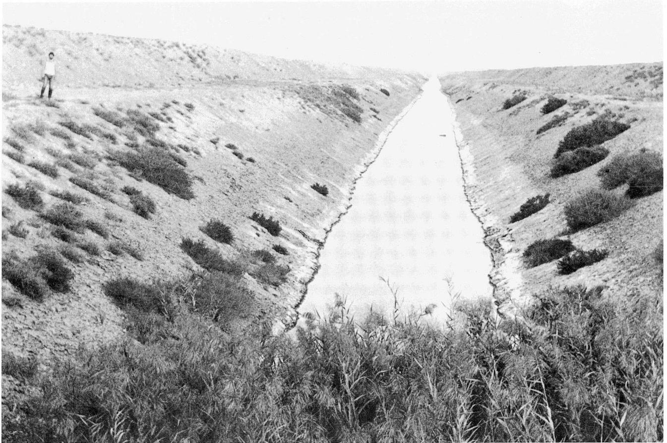
1 Entwässerungskanal des Hillāh-Diwaniyāh-Projektes: Main Drain IV am Übergang bei km 37,22. Blickrichtung nach Südost. Kanaltiefe bis zum Grundwasser: 5,50 m. Im unteren Drittel der Wände weiße Salzausblühung. Im oberen Drittel Grenze zwischen kapillar durchfeuchtetem (dunkel) und völlig ausgetrocknetem Boden (hell). Foto: 18. 10. 78.
