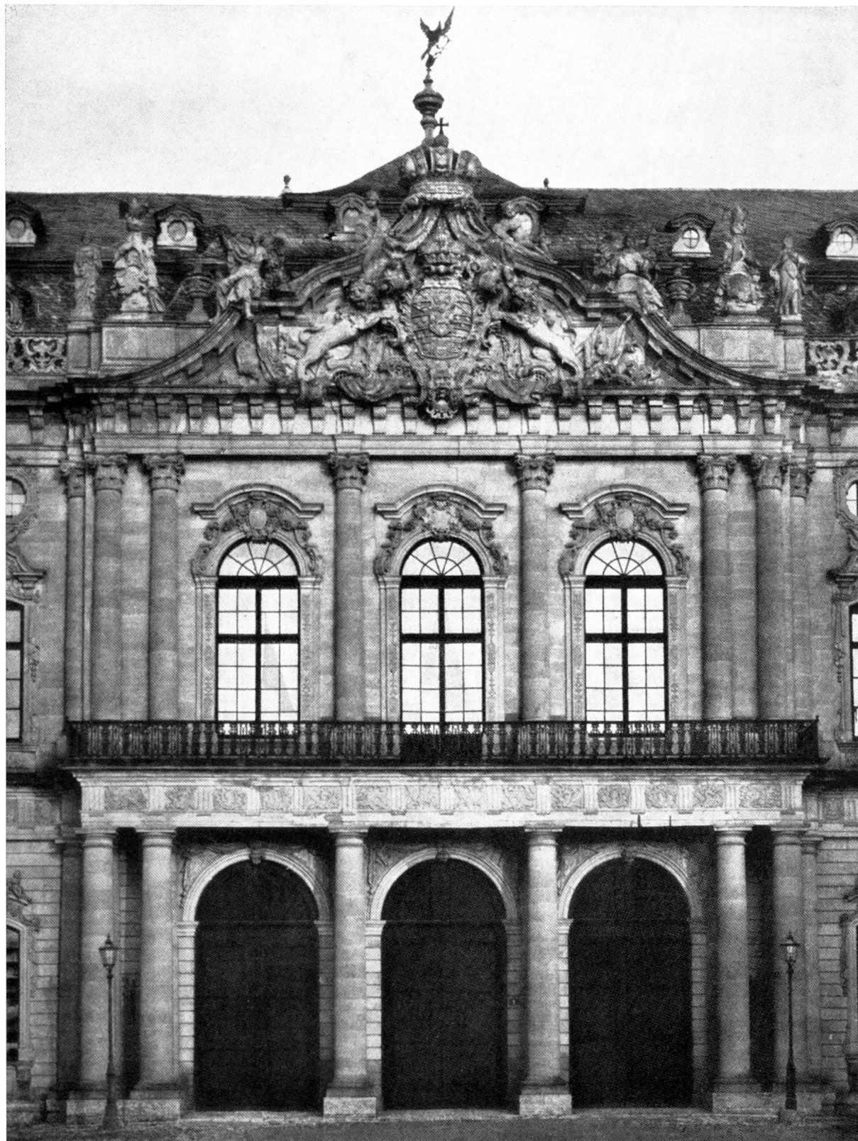
Residenz in Würzburg: Portalfassade
