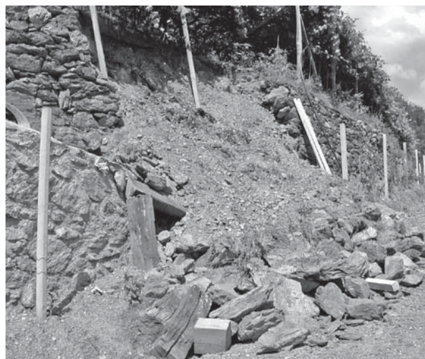
Beschädigte Stützmauer
