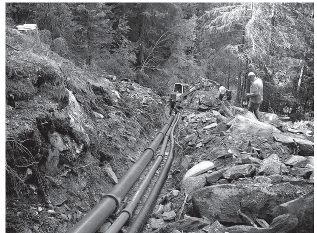
Verlegen der Rohre für das Kleinwasserkraftwerk Moos
