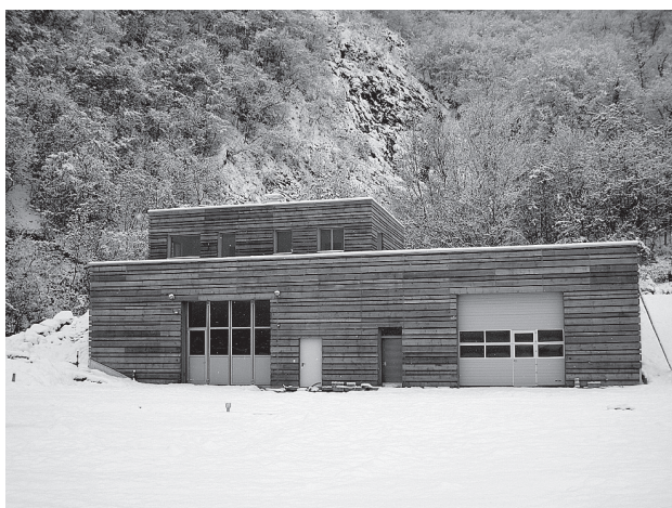
Neue Lagerhalle mit Sanitärräumen im Forstgarten Piglon – Pfatten gemeinsam mit der Gutsverwaltung Laimburg.
