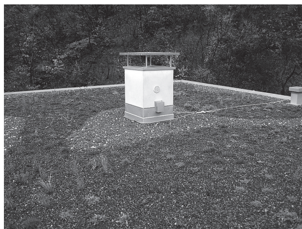
Dachbegrünung im Obergeschoss.
