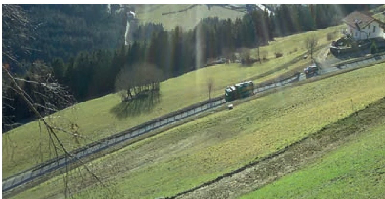
... und nach Behebung der Unwetterschäden
