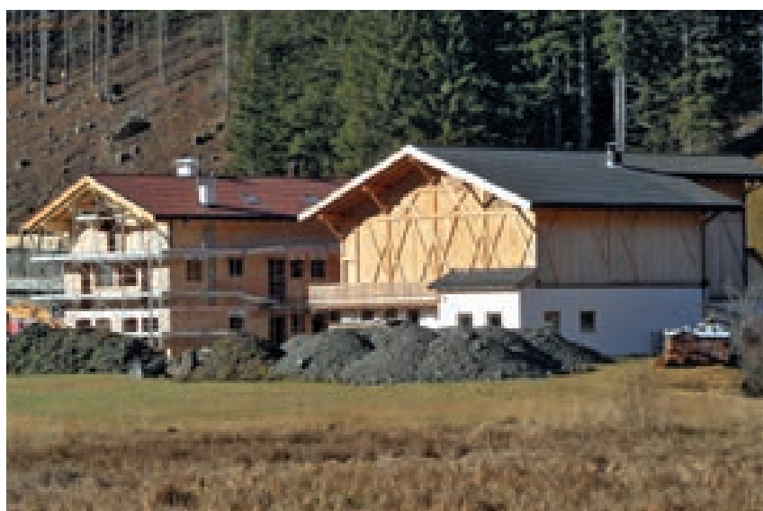
Neubau einer Hofstalle
