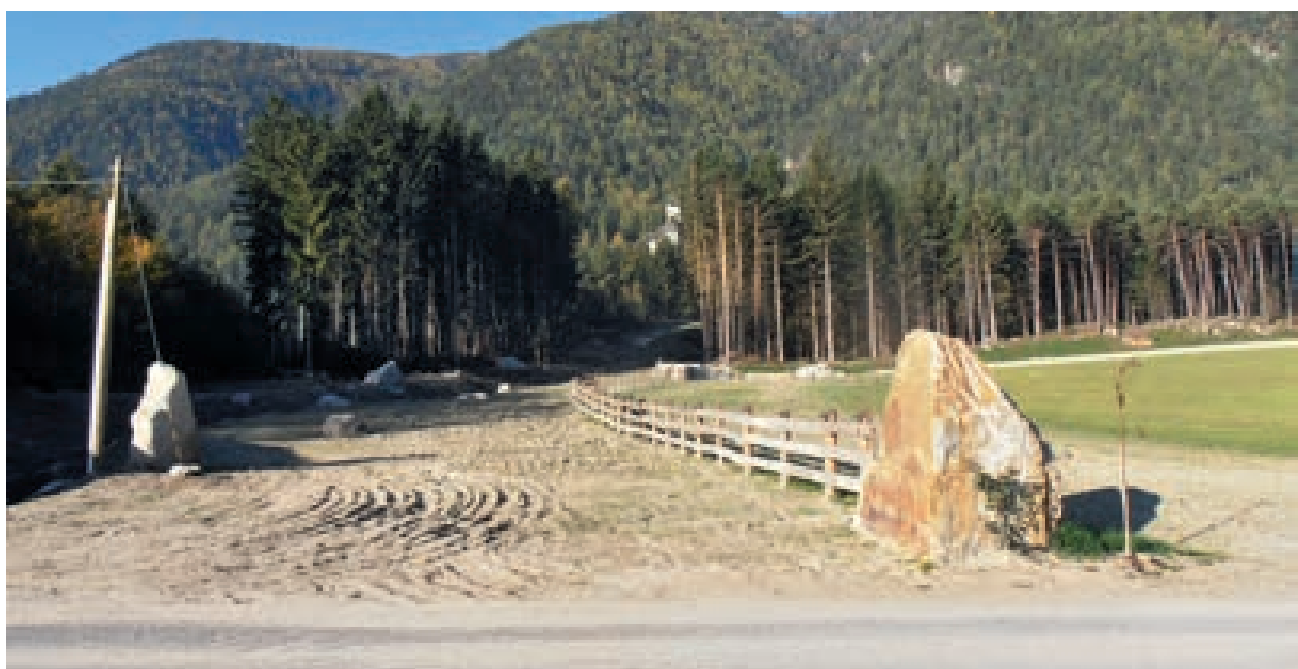
u. nd nach der Behebung der Unwetterschäden
