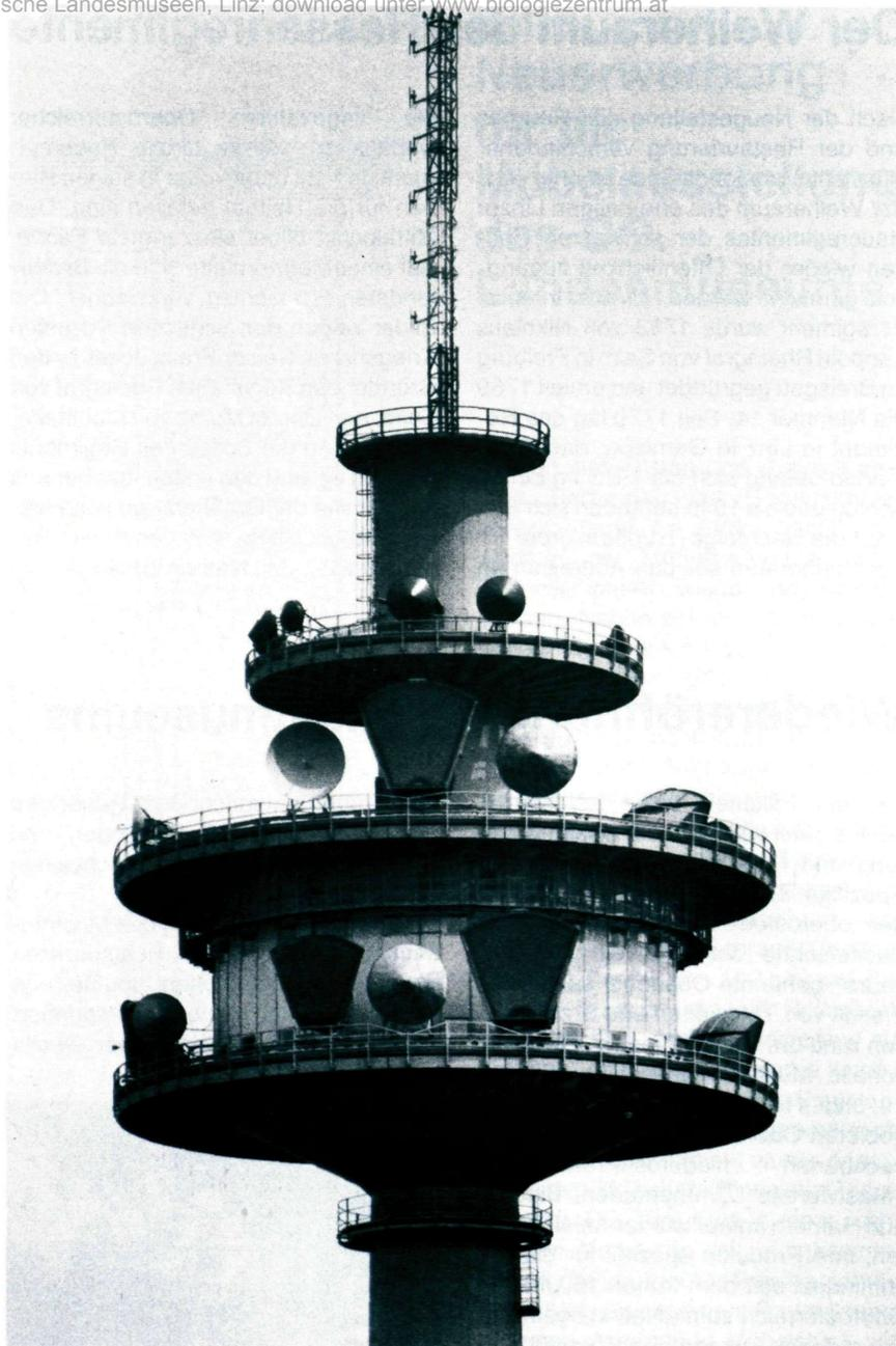
*Der Richtfunkmast Ansfelden bei Linz ist eine Relaisstelle für die Richtfunkstrecke Wien–Innsbruck mit einer Abzweigung zum Hauptbereichsamt Linz und dient der Übertragung des nationalen und internationalen Fernmeldeverkehrs sowie als Programmzubringer des ORF.*
