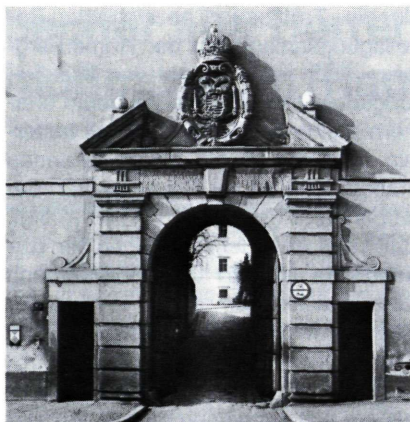
Abb. 2: Rudolfstor. Das der Altstadt zugekehrte Tor erinnert an den Erbauer des heutigen Schlosses Kaiser Rudolf II. Über gequadrerten toskanischen Wandpfeilern aus Granit mit Gebälk umschließt ein gesprengter Giebel das Wappen Österreichs mit der Krone des Kaisers. Im Gebälk die Inschrift: RUDOLPHUS · II · IMP · CAES · P · I · AUGUST · ROM · GERMAN · HUNGAR · BOEM · ZC · REX ARCHID · AUST · DUX · BURGUND · ZC · ANNO · MDCIII
