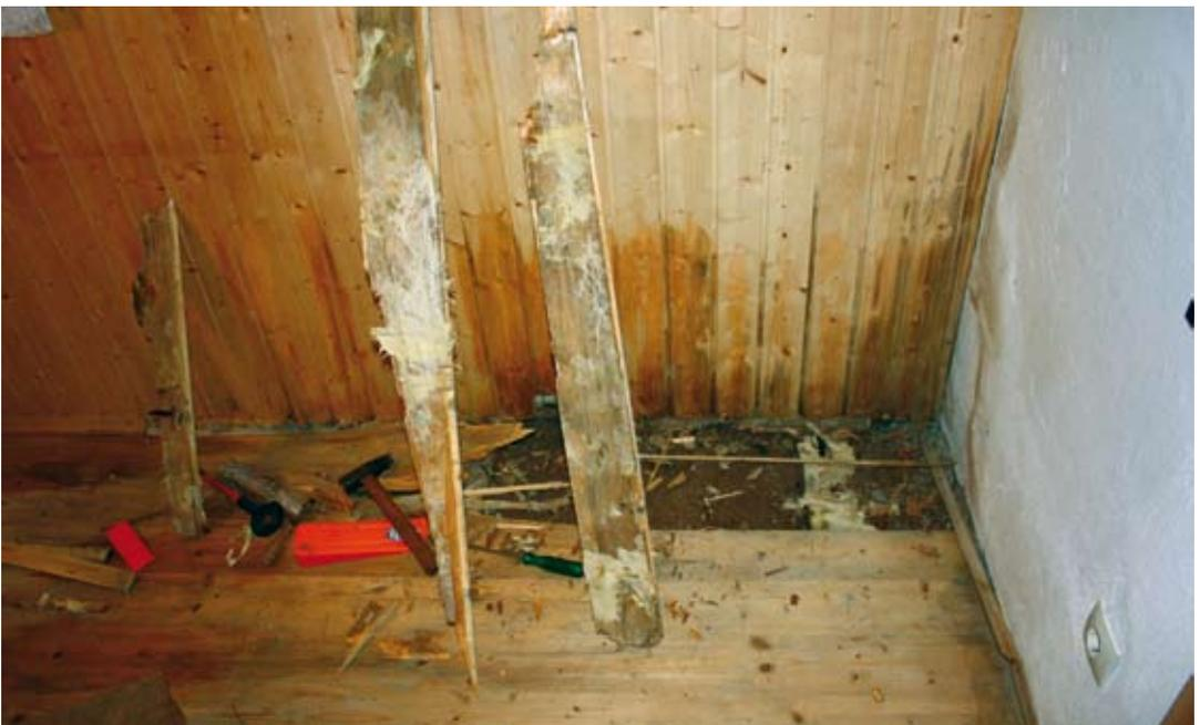
Abbildung 2. Die Ausbreitung des Hausschwamms auf dem Substrat erfolgt zunächst mit weißen Mycelsträngen, hier in einem Haus in der Oberpfalz, August 2010.– Foto: M. SCHOLLER.
