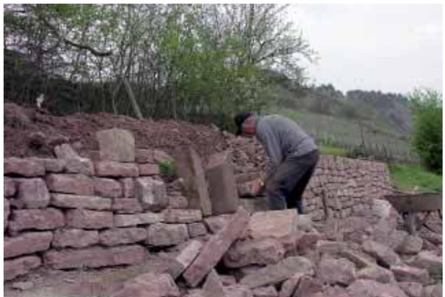
**Abbildung 20:** Bau einer Trockenmauer
