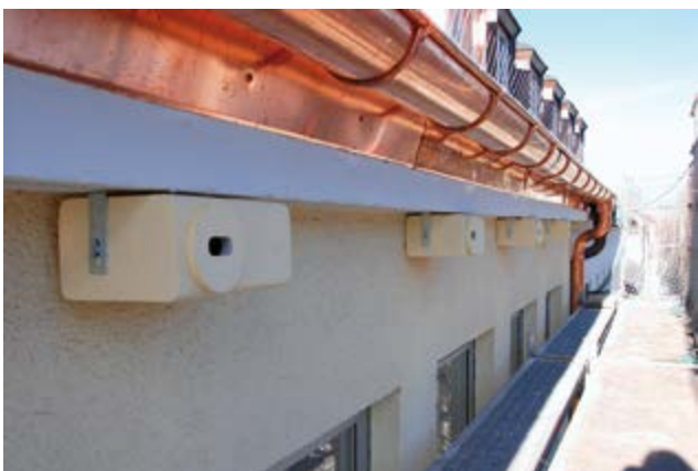
Abb. 3: Nach einer Sanierung unter dem Dachüberstand angebrachte Nistkästen sollten genau unter den früheren Quartieren liegen, um schneller gefunden und angenommen zu werden (Foto: Sylvia Weber).
