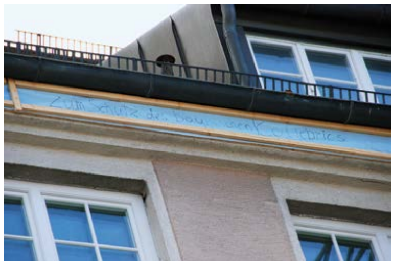
Abb. 2: Wer Gebäudebrütern den Zugang zu ihren Quartieren verwehrt, braucht dazu eine Genehmigung der Höheren Naturschutzbehörde. Die Aussperrung muss unbedingt frühzeitig vor der Rückkehr der Tiere erfolgen und nach Sanierungsende wieder entfernt werden. In dem Beispiel wurden die Zugänge zu den Brutplätzen, hinter der Regenrinne liegend, mit Holzlaten und einer Folie für die Dauer der Baumaßnahme verschlossen (Foto: Sylvia Weber).
