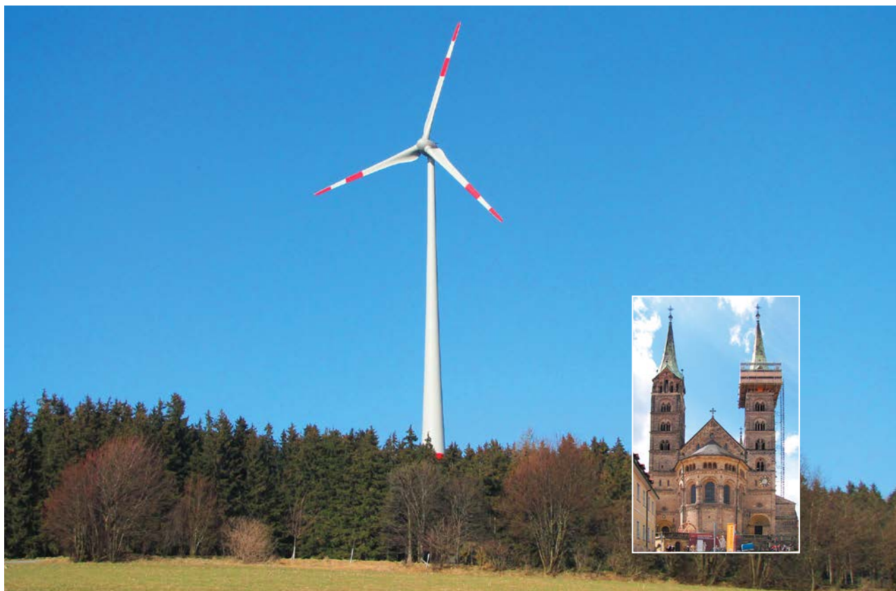
Abb. 3: Ein modernes Windrad mit 200 m Gesamthöhe ist beinahe dreimal so hoch wie der Bamberger Dom (Fotos: Michael Grauvogl).
