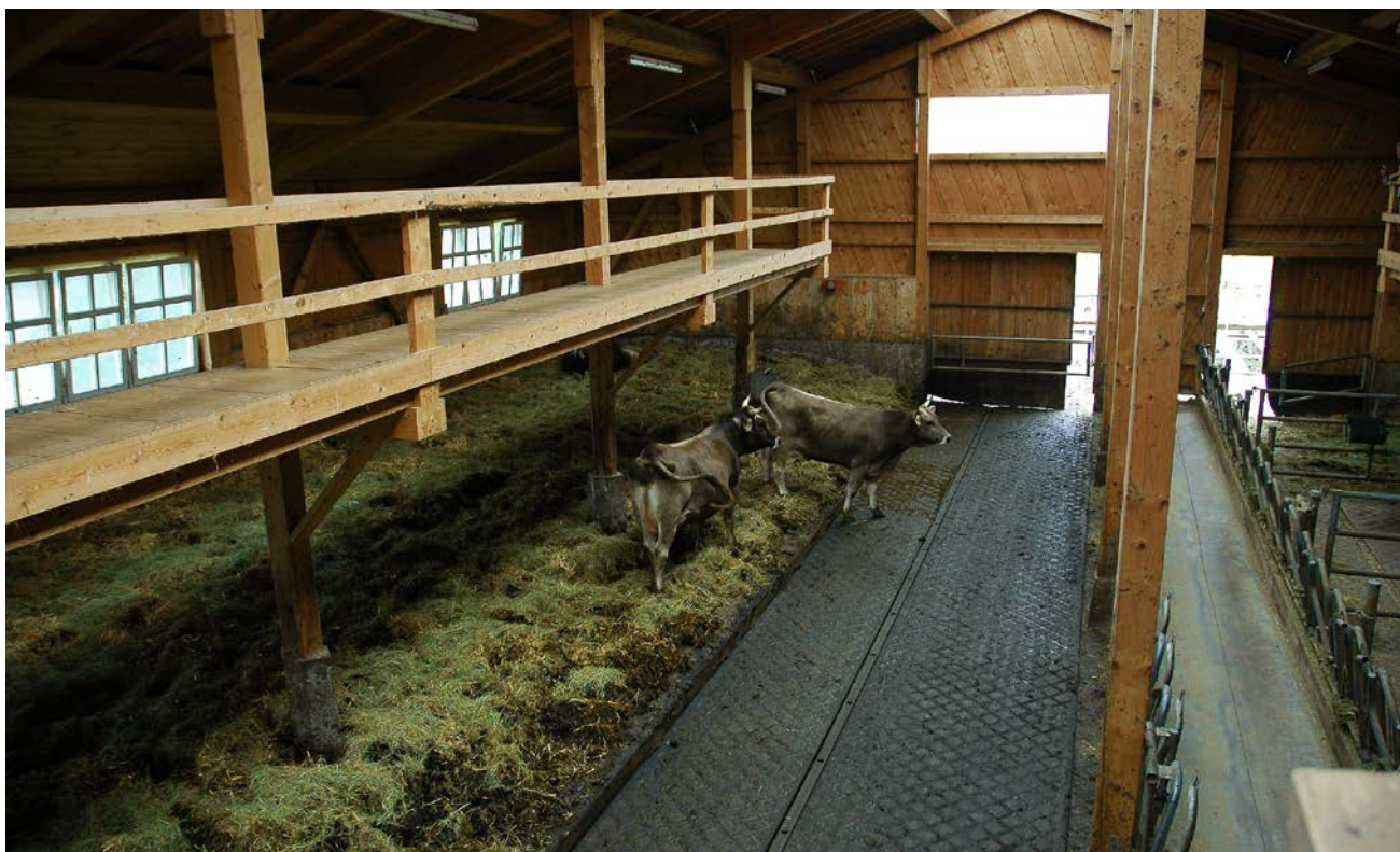
Abb. 3: Im Rahmen des Projekts konnten zahlreiche effiziente Methoden, die sich einzelne Landwirte zur Nutzung der Einstreu ausgedacht haben, dokumentiert und kommuniziert werden (ZEHM et al. 2009). Das Beispiel zeigt einen Tretmiststall, bei dem über einen Laufgang von oben effizient Streumaterial im Stall verteilt werden kann (Foto: Andreas Zehm).
