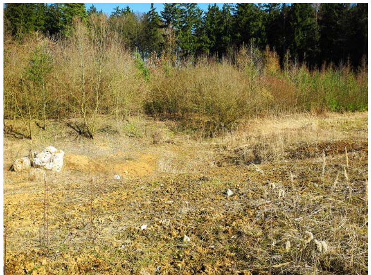
Abb. 1: Eine gut gemeinte Artenhilfsmaßnahme ohne Berücksichtigung der Standortbedingungen: Die gewünschte Wasserfläche der Abgrabung blieb aus, da nach der Rekultivierung das Wasser im durchlässigen Boden versickerte. Auch eine nachträglich aufgebrachte Lehmschicht und zusätzliche Verdichtungsmaßnahmen brachten nicht den gewünschten Erfolg. Hier wäre es besser gewesen, bestehende Strukturen – möglichst auch während der Rekultivierung – zu belassen (alle Fotos: Hoffmann Mineral GmbH).
