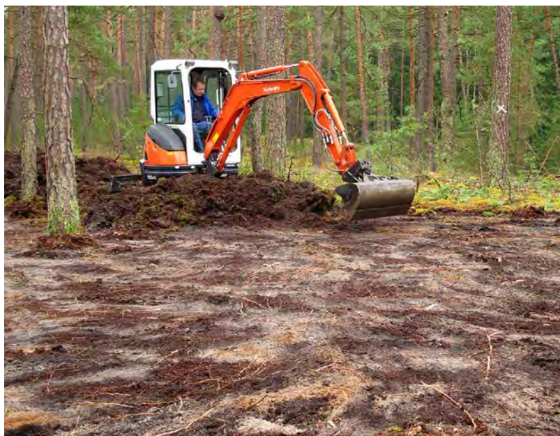
Abb. 3: Entfernen der Rohhumusdecke mit einem Minibagger im Frühjahr 2012 (Foto: Wolfgang von Brackel).
