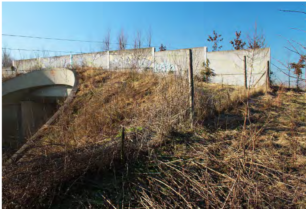
Schmale Grünbrücken wie in diesem Beispiel eignen sich häufig nicht für die Vernetzung anspruchsvoller Tierarten. Haselmäuse sind beispielsweise auf schützende Gehölzbestände angewiesen, um Querungshilfen nutzen zu können (Foto: Norbert Hirneisen/piclease).
