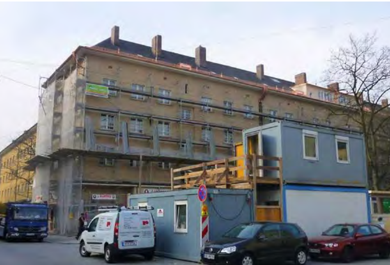
Abb. 2: Das Gerüst wurde gemäß Auflage der Höheren Naturschutzbehörde rechtzeitig vor Rückkehr der Mauersegler in Teilbereichen rückgebaut, so dass sie ihre Lebensstätten anfliegen können.
