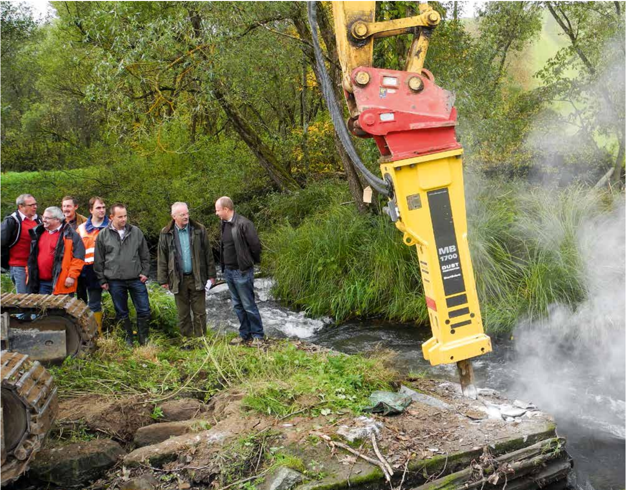
ABBILDUNG 4 Abriss der letzten Wanderbarriere. Ab jetzt gibt es an der Mitternacher Ohe wieder freie Fahrt für Huchen, Bachneunauge und die Larven der Flussperl- muschel (Bild: LFV).
