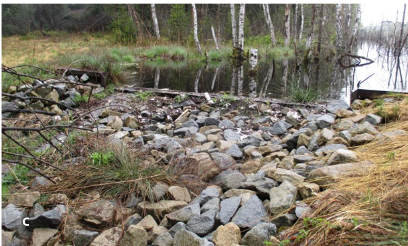
Abbildung 3 (a) Ein Moorbagger rammt im Eglinger Filz die Metallspunddielen in den Boden (Foto: Cornelia Siuda). (b) Fertiger Spunddamm drei Jahre nach Fertigstellung bei Vollstau (maximales Stauziel erreicht; Wassertiefe am Damm etwa 0,6 m, von dort innerhalb des überstauten Torfstichs flach auslaufend) (Foto: Cornelia Siuda). (c) Geregelter Überlauf der Dammscharte bei Vollstau Ende April 2019; die Wasserbausteine liegen auf Vlies, um nicht in den weichen Mooruntergrund einsinken zu können (Foto: Cornelia Siuda).
