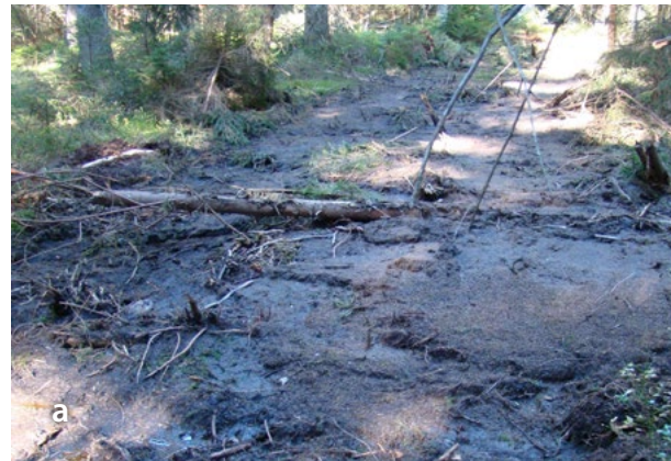
Abbildung 10 a) Entwässerungsgraben im Fichtelseemoor direkt nach der Verfüllung (Foto: Manfred Scheidler) b) Entwässerungsgraben 4 Jahre später: Flächiger Sphagnum-Bewuchs (Foto: Manfred Scheidler). c) Wiedervernässung im Moorwald (Foto: Manfred Scheidler).
