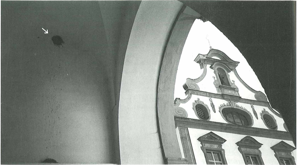
Abb. 1: Lage des erfolgreichen Gebäudebrutplatzes der Felsenschwalbe in der Altstadt von Füssen, Innenhof des Klosters Mang, Südostflügel, im tiefen Portal. – Successful breeding site of the Crag Martin in Füssen, "Mang monastery", southeast wing, in the deep portal.
