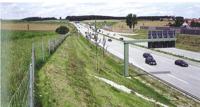
Foto 4. Landschaft an der A 8 nach sechsspurigem Ausbau. Rodung der Heckenstreifen, Zäunung und Erdwälle haben die Verluste stark reduziert. – Landscape at the Highway 8 after the six-lane extension. Clearing of the hedges, fencing and ramparts have strongly reduced the mortality.
