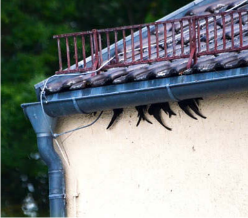
Abb. 17. Mauersegler Apus apus (tot hinter Dachrinne). – Common Swift (dead birds behind rainwater gutter), Ismaning M, 08.06.2013.
