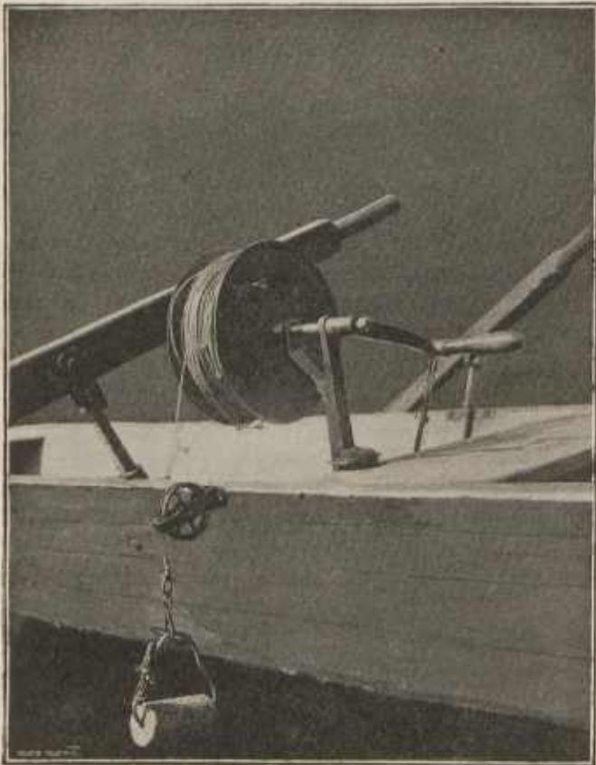
Fig. 10. Apparat zu Tiefenmessungen. Photographirt von Dr. V. Vávra.
