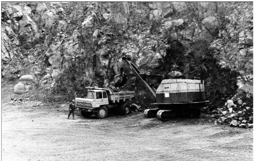
Abb. 17. Haufwerksverladung Mittels Seilzugbagger. Basaltsteinbruch Pauliberg: Abbaustadium 1971.
