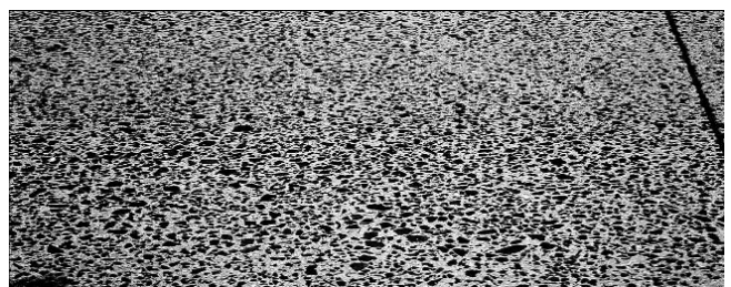
Abb. 27. Verwendungsbeispiel für den Basalt vom Pauliberg im Straßenbau. Betondecke der Südbahn zwischen Wiener Neustadt und Seebenstein. Durch den verkehrsbedingten Abrieb der ursprünglich hellgrauen bis fast weißen Betondecke werden die dunklen Basaltsplitte – vor allem in den Radspuren – sichtbar.
