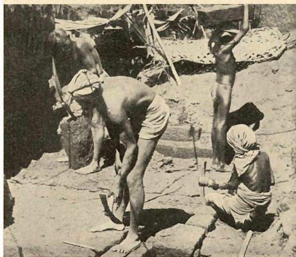
Bild 7. Bausteine werden aus dem Laterit herausgehauen.
