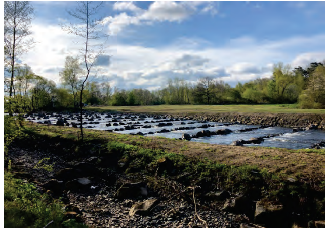
Abb. 3: Neue Sohlgleite südlich der Schladener Fischteiche. Foto: C. Bobzin
