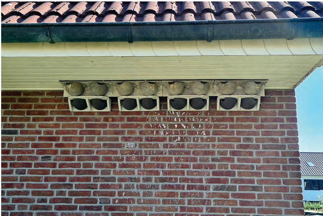
Abb. 19: Nordseite mit acht Doppelnestern für Mehlschwalben, 25.06.2024
