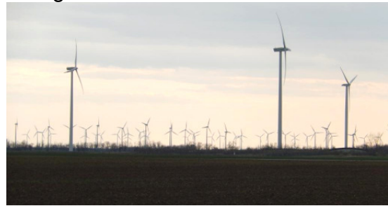
Windpark auf der Parndorfer Platte im Nordburgenland
