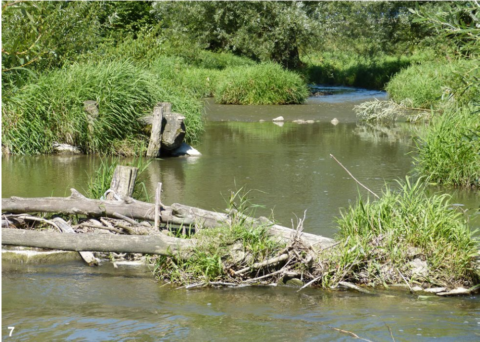
Abb. 6–7: (6) Aufweitung sowie (7) Holzbuhnen und Buchten in der Untersuchungsstrecke Pram 3 in Zell. / (6) Widening of the river and (7) wooden groynes and river coves in stretch Pram 3 in Zell. © A. Chovanec.
