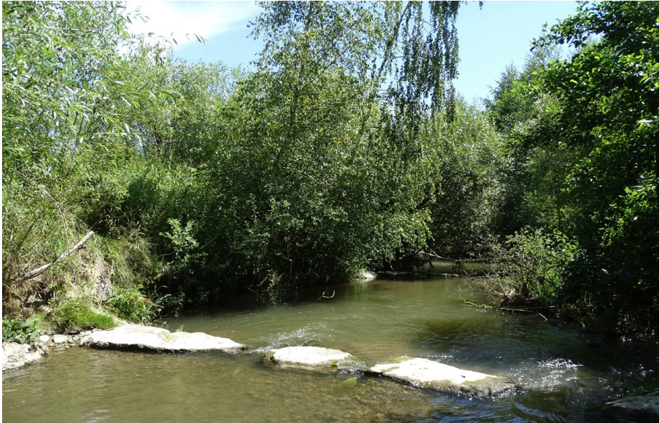
Abb. 4: Aufgelöste Sohlrampe im Leitenbach mit höherer Strömungsgeschwindigkeit, 14.7.2022. / Fish-passable rock-ramp in the Leitenbach with higher flow velocity. © A. Chovanec.
