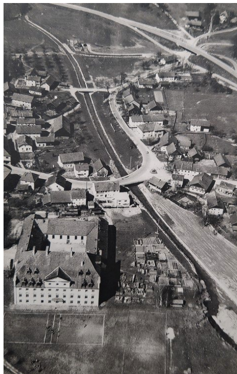
Abb. 1: Regulierung der Pram in Zell Ende der 1960er Jahre. Im Bereich des Schlosses sind ein Teil eines ursprünglichen Mäanders und die Bauarbeiten am neuen begradigten Gerinne zu erkennen (aus SAGEDER 2015a). / The regulated river Pram in Zell at the end of the 1960s. Near the castle a part of a meander and the newly constructed straightened riverbed can be seen.
